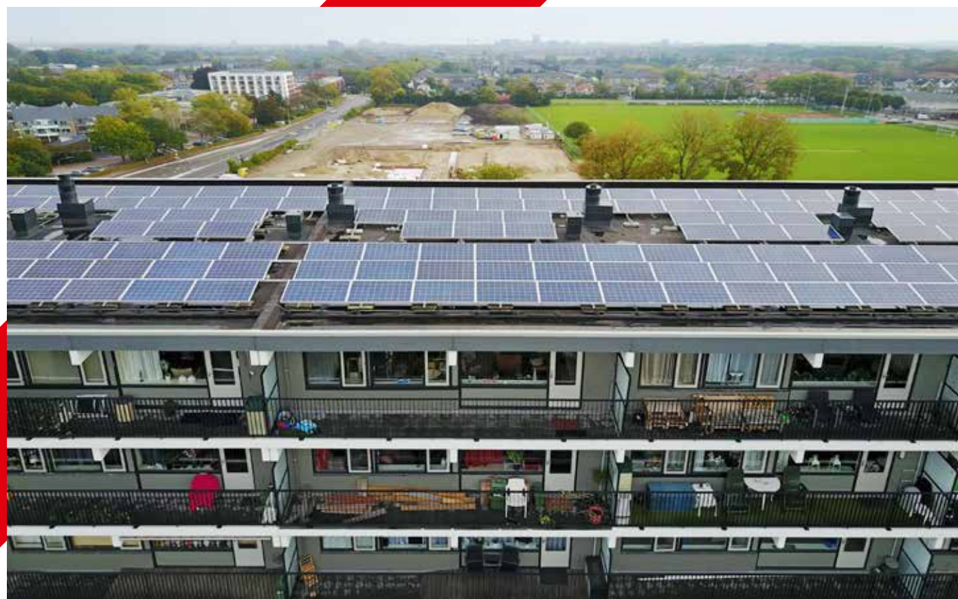
De hoge flat aan de Aubadestraat ligt vol met zonnepanelen.
